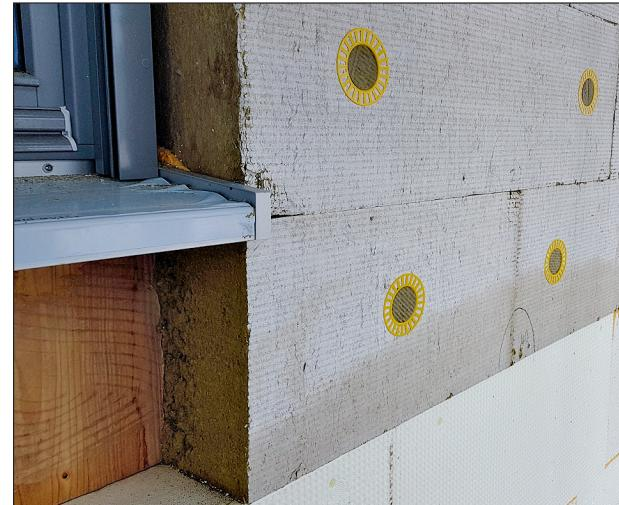
Schmalkanten ohne Bewitterungsschutz: eine offene Flanke für den Wassereintritt bei Wärmedämmverbundsystemen
