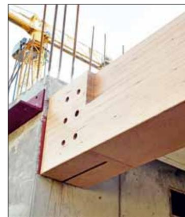
Schnittstelle Holz-Beton: Anschluss eines Buchenträgers an Stahlbetonwand mittels Ankerplatte und Stahlschwert.
