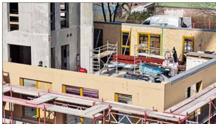
Alle Gebäude wurden in Hybridbauweise errichtet, im Bild ein Treppenhaukern in Stahlbeton und die Holztafelemente mit bereits werksseitig eingesetzten Fenstern.
