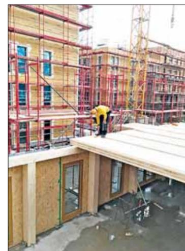
Montage des Tragwerks, der Hintergrund macht die beengten Verhältnisse auf der Baustelle deutlich.
