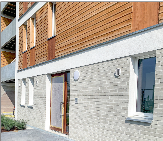
Detail der Fassade im Projekt Vogelkamp: Erdgeschoss als Massivbau in Mauerwerk erstellt und verkleinert, die darüber liegenden Geschosse als Holzmassivbau in Brettsperrholz ausgeführt. Zur Isolation wurden Holzrahmenelemente mit Dämmung und einer Außenhaut aus unbehandelter Lärche verbaut.
