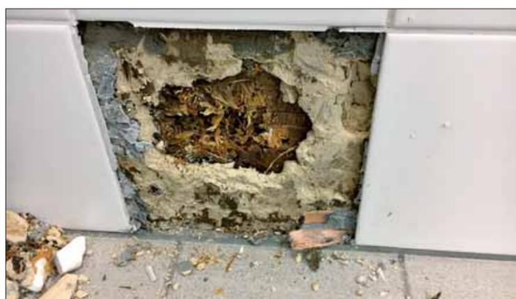
Die planmäßige Verbundabdichtung mit Fliesenbelag verhindert keine Holzschäden infolge Wasserleitungsschäden.
