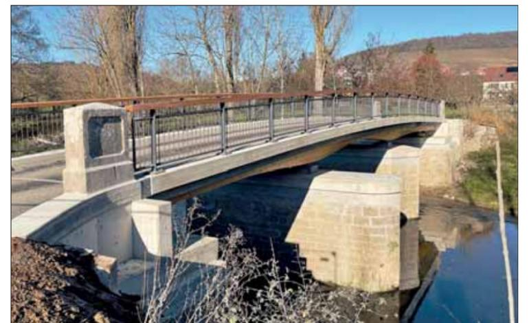
Die Verwendung von Holz für das Brückentragwerk und die Erhaltung der Naturstein-Pfeiler und -Widerlager machen den Ersatzneubau der Tauberbrücke in Weikersheim zu einem Bauprojekt mit vergleichsweise geringen CO<sub>2</sub>-Emissionen.
