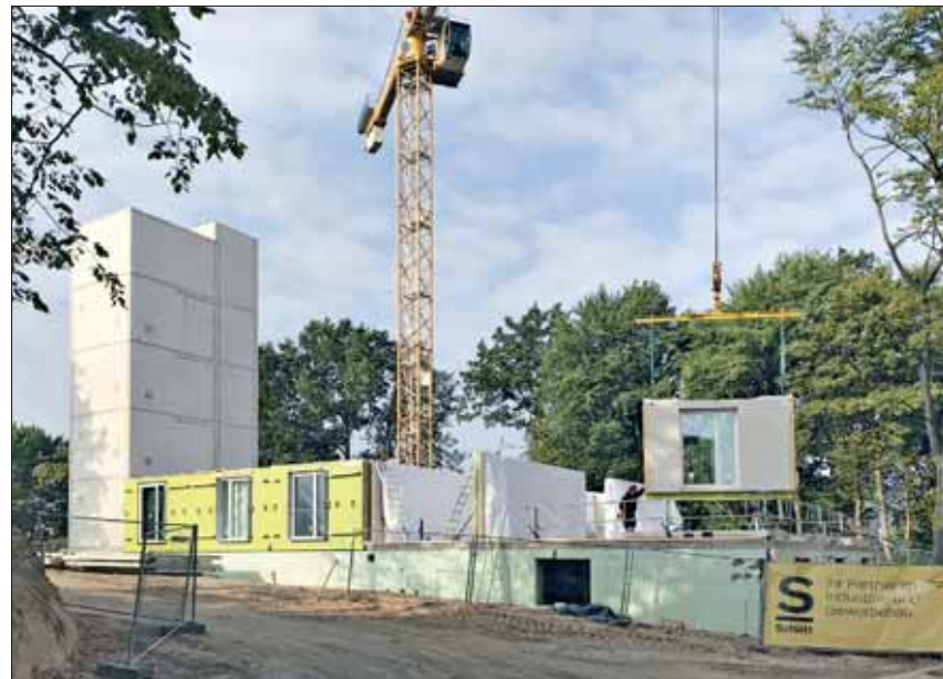
Mehrgeschossiges Bauvorhaben (Studierendenwohnheim) in Holzhybridbauweise mit Qualitätssicherung Foto: M. Mohrmann
